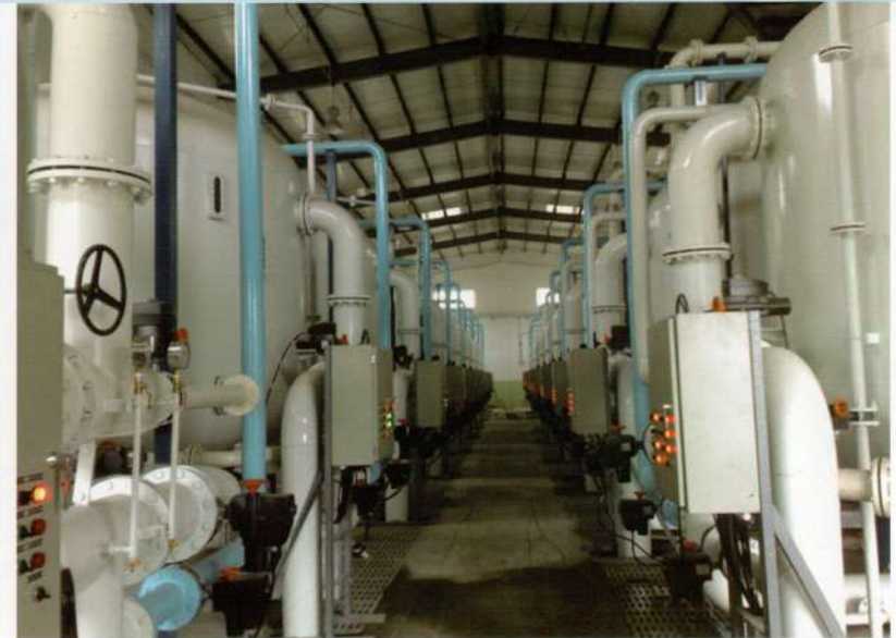
沈阳石蜡化工有限公司 多介质、锰砂过滤器 Shenyang Paraffin Chemical Industry Co., Ltd.
