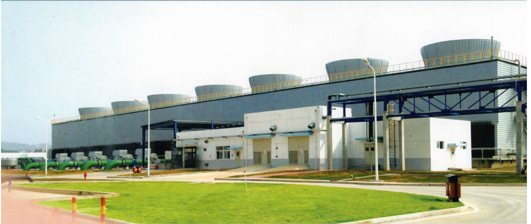
福建天辰耀隆新材料有限公司 Fujian Tianchen Yaolong New Material Co., Ltd. 20万吨己内酰胺工程12台SHN-4700型冷却
