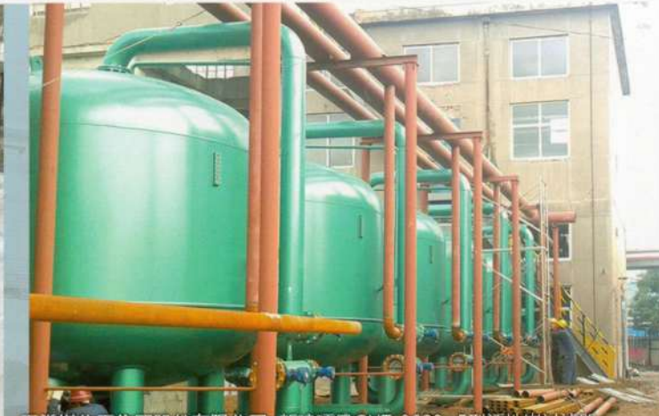
天普煤化工集团股份有限公司 新建项目GHT-3600x5型活性炭过滤器 Shanxi Tianji Coal Chemical Industry Group., Ltd.
