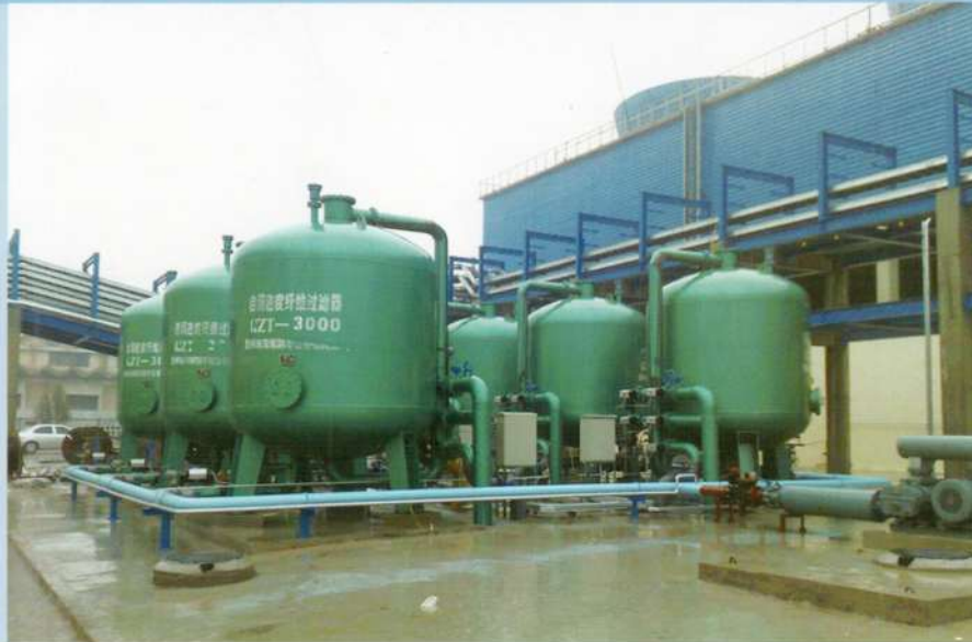
辽宁华锦化工(集团)有限责任公司 12台GZT-3000型纤维过滤器 Liaoning Huajin Chemical Group Co., Ltd.
