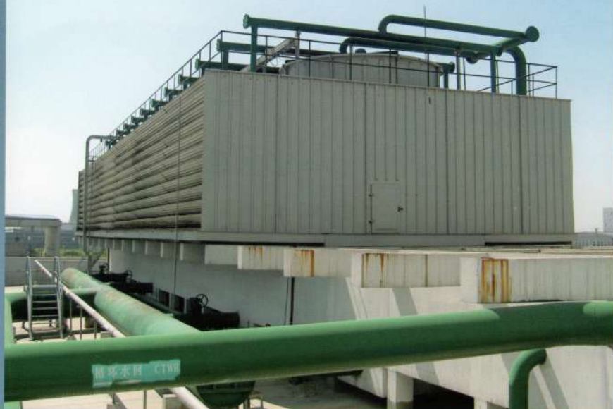
晋煤金石化工投资集团有限公司 Jincheng Anthracite Jinshi Chemical Industry Investment Group Co., Ltd. 2组BNZF-500X2型冷却塔
