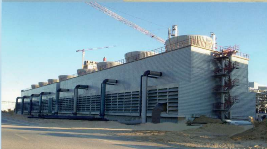
鄂尔多斯亿鼎煤化工有限责任公司 Erdos City Yiding Coal Chemical Industry Co., Ltd. 8台SHN-4500型冷却塔
