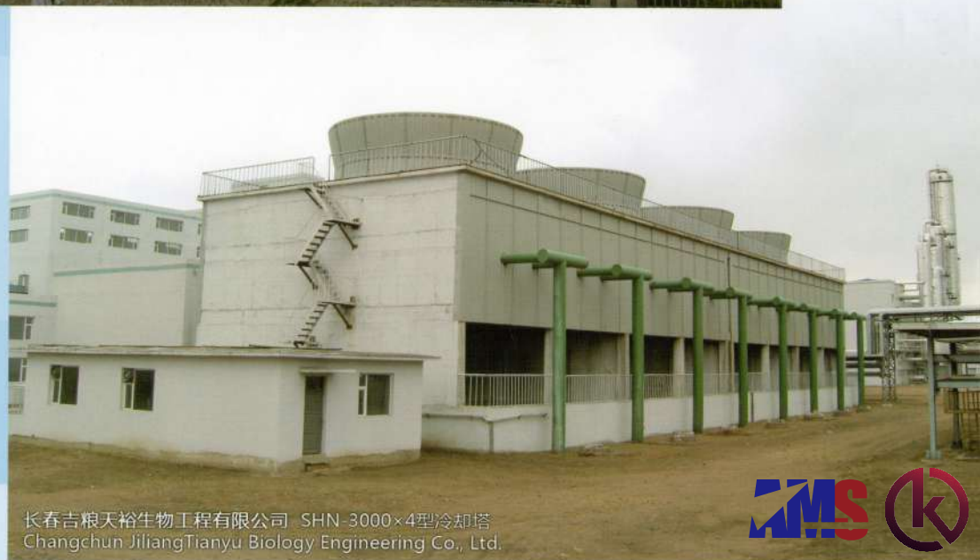
安徽丰原燃料酒精有限公司 Anhui BBCA Biochemical Co., Ltd. NG-1500×7型钢结构冷却塔
