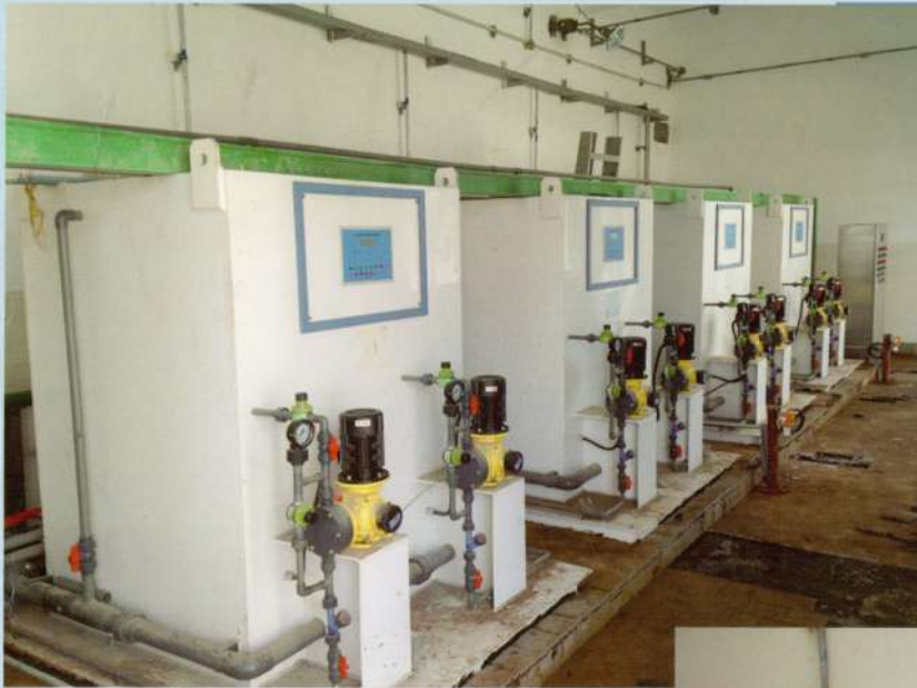
中国天辰宁波江宁化工有限公司 China Tianchen Engineering Corporation (TCC) SH-20kg二氧化氯发生器
