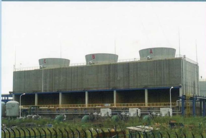
扬子石化 Sinopec Yangzi Petrochemical Co., Ltd. 单喷嘴冷壁式粉煤加压机工业化示范装置 SHN-5000×3型冷却塔
