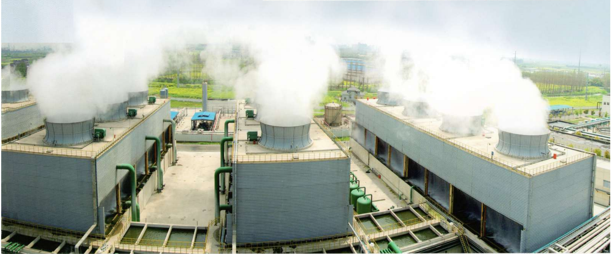
江苏海伦石化有限公司 Jiangsu Hailun Petrochemical Co., Ltd. 120万吨K-EPTA工程14台SHN-6000型冷却塔，为国内最大单台循环水量冷却塔
