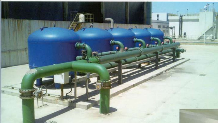
晋煤金石化工投资有限公司 3台SHGF-1200型浅层砂过滤器 Jincheng Anthracite Jinshi Chemical Industry Investment Group Co., Ltd.
